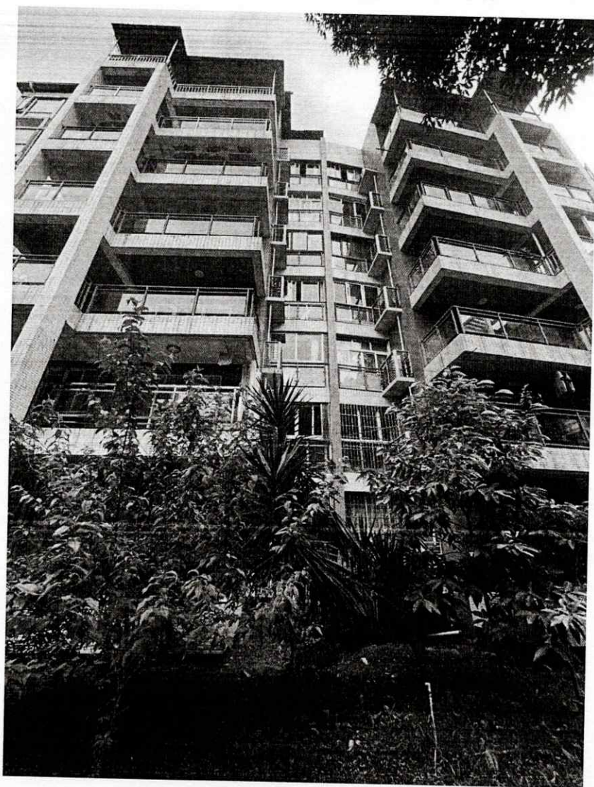
图 1-1 大足区棠香街道东关社区新东方花园小区 5 幢增设电梯工程外观图
