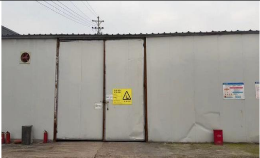
2 号地块危废贮存库
